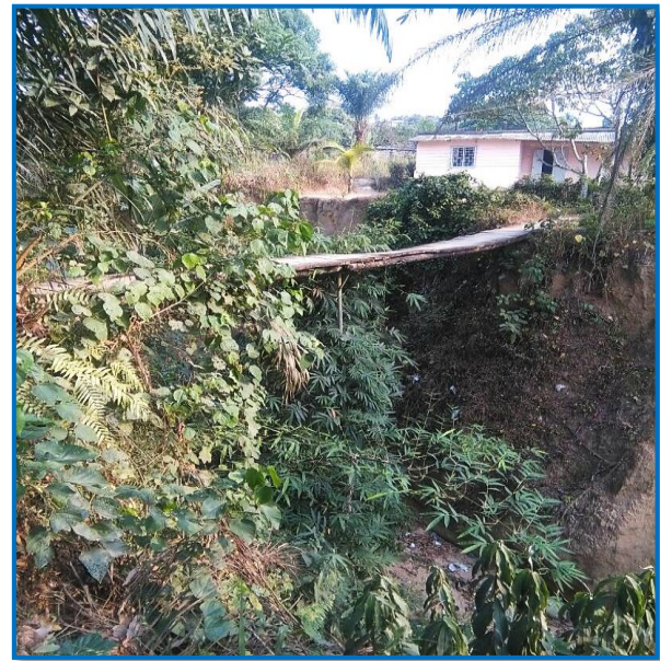
Photo 3.2: Pont de fortune (tronc d'arbre), menant à une maison construite sur un site à risques à Douala
